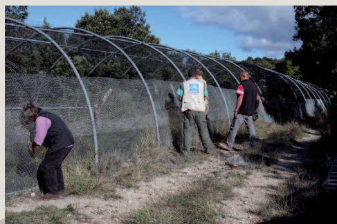
Chantier de bénévoles pour la réparation d'une volière de réhabilitation.
